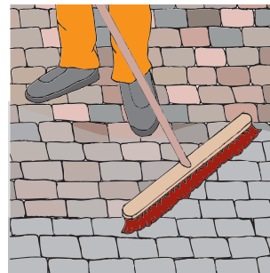
Trockenen Mörtel einkehren
